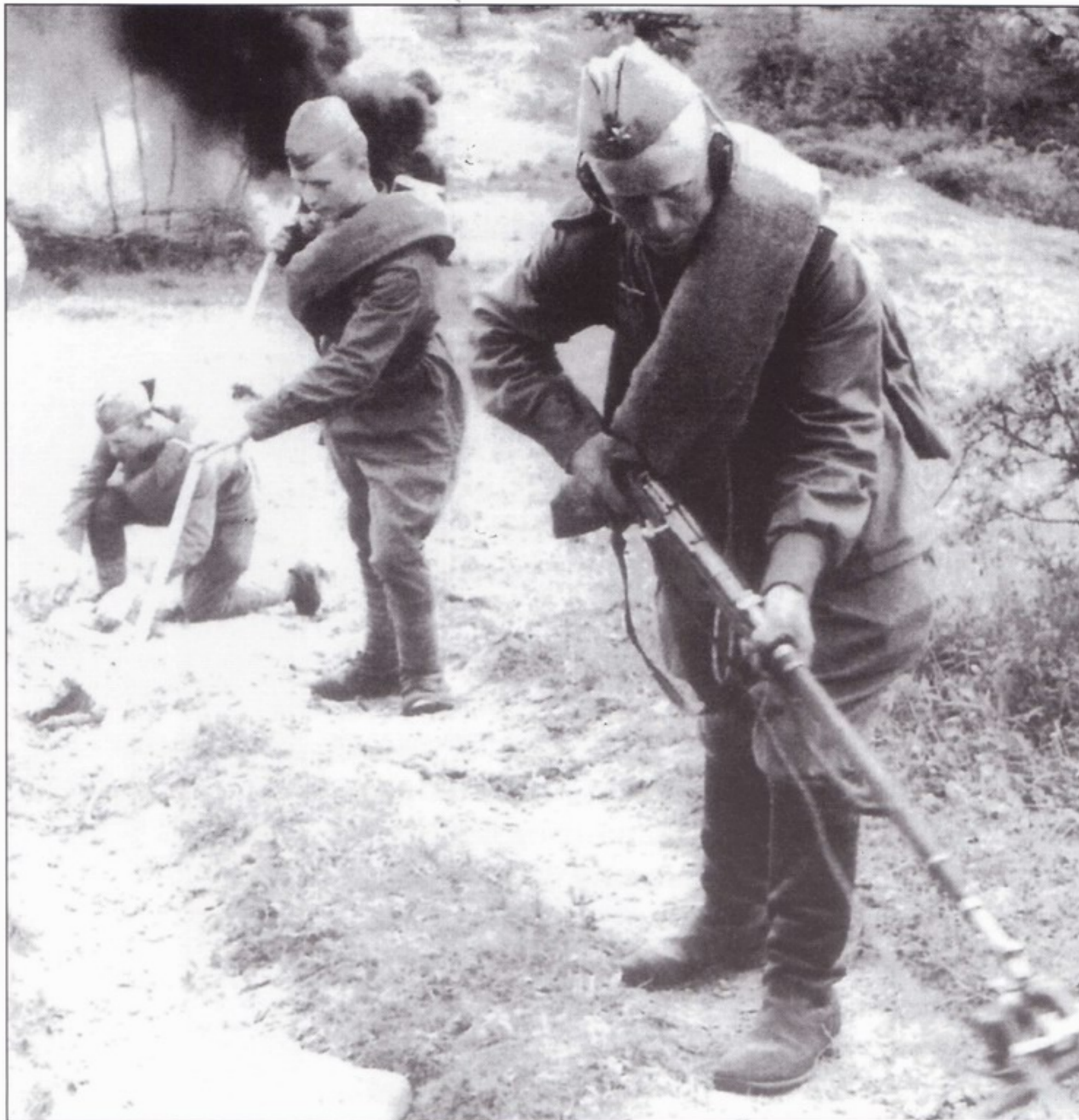
Саперы ищут мины с помощью щупа и миноискателя ВИМ-210.
